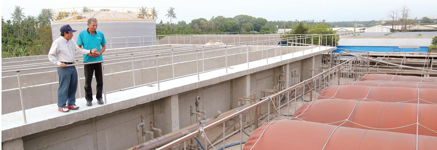
▲中央畜牧場斥資興建大型厭氧池、沼氣袋、高壓除氣桶、脫硫裝置、發電機，是台灣較具規模的沼氣發電示範區。
